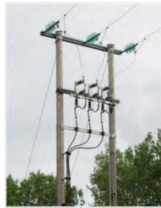
Kabelavgreiningsmast
