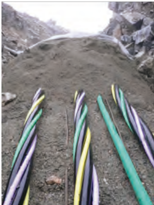
Jordkabel i grøft
